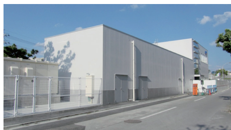
再生医療研究センター外観
